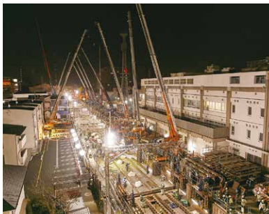
▲クレーンによる切替え作業
