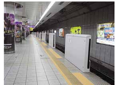
⑥設置完了
