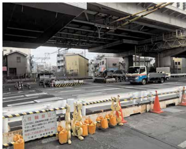
▲産業道路第1踏切道除却後
