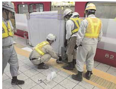
⑤ベースプレートの位置に合わせてホームドアを取り付け
