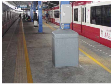
▲京急川崎駅 下りホーム
