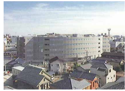
▲金沢文庫現業事務所 外観
