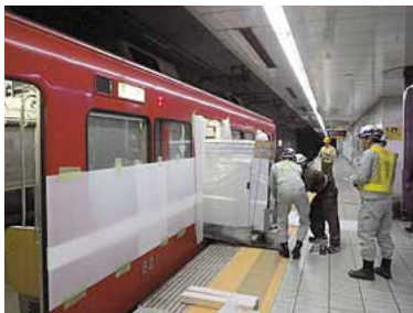
④ホーム到着後、養生して作業開始
