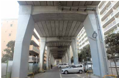
▲鮫洲～立会川駅間
