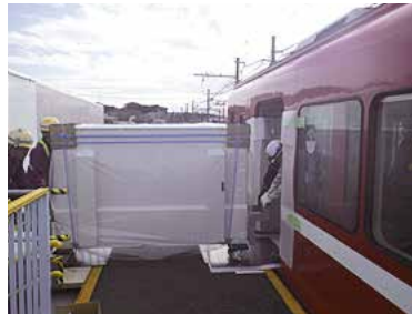
②ホームドアにも車両にも傷がつかないように養生して搬入
